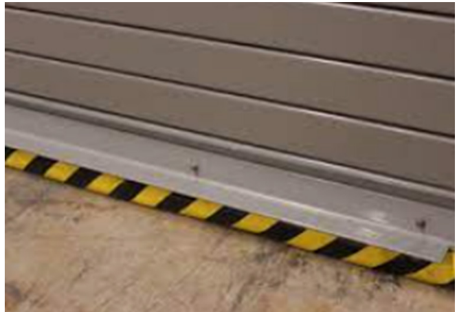
Figure B9: Sensing Edge
